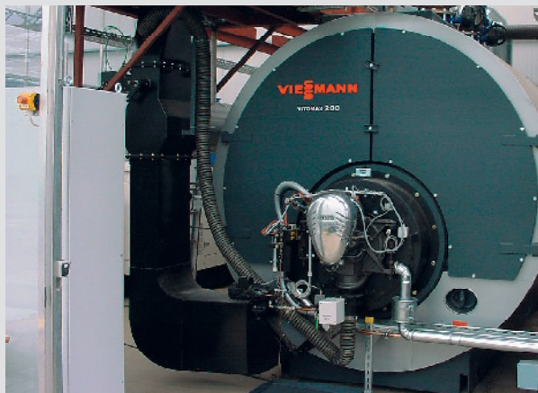
Vitomax 200-LW (тепловой мощностью 16,5 МВт)
